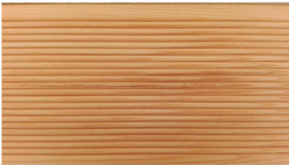
Fot. 2 - pęknięcie typu włos
