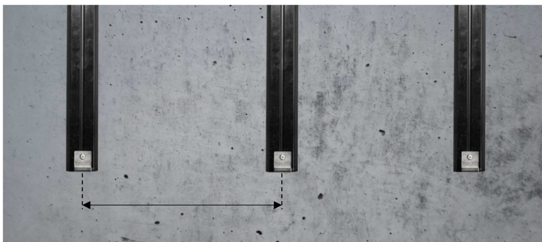
Rysunek 1. Taras na podłożu betonowym
