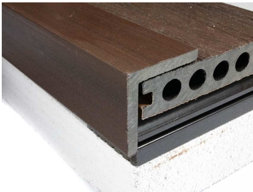
Rysunek 22. Montaż listwy za pomocą kleju elastomerowego od strony bocznej desek
