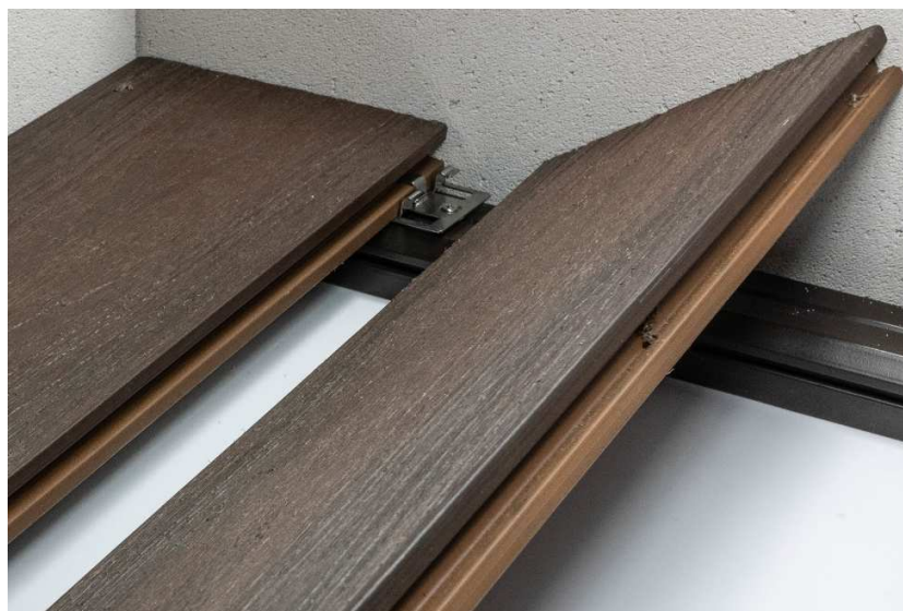
Rysunek 15. Montaż kolejnej deski na klipsie montażowym
