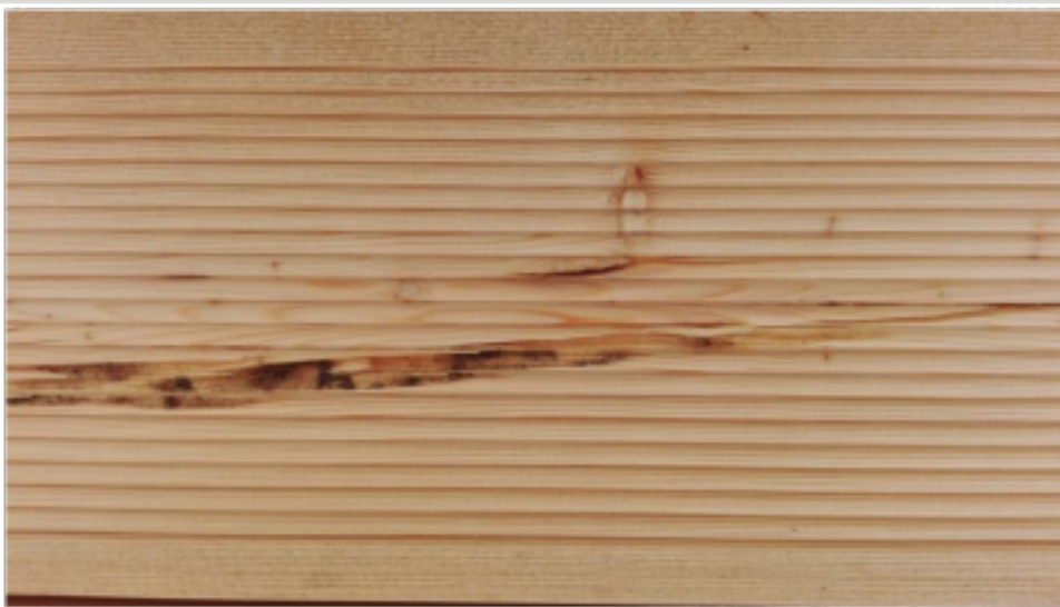
Fot. 4 - pęknięcie wzdłużne
